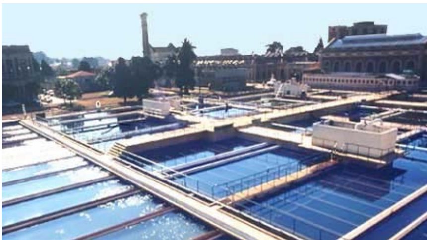
Foto N°4 Planta potabilizadora Gral. San Martín (CABA)
